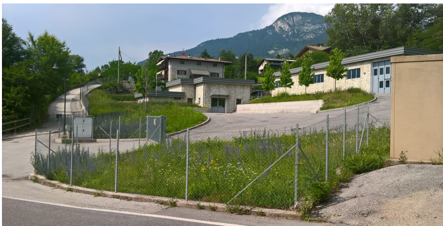
Figura 1.2: Foto della sorgente delle Laste.
