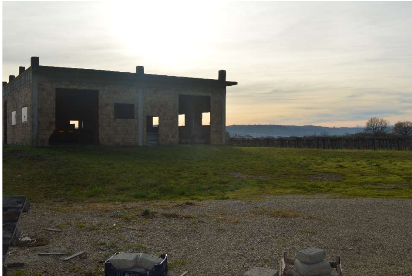
Figura 10 Foto di un sito marcato per intervento in località Piattelli
