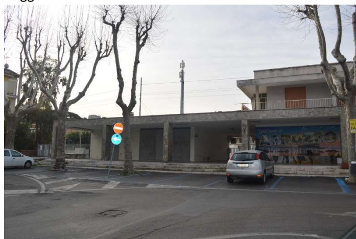
Figura 16 Stazione ferroviaria di Francavilla al Mare
